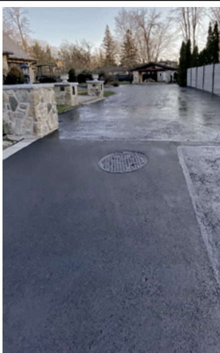
RÉPARATIONS D'ASPHALTE + SCELLANT ASPHALT REPAIR + SEALING
